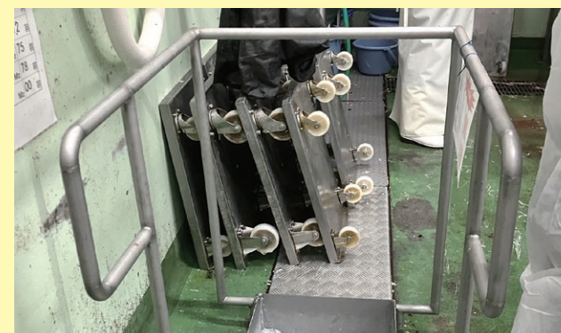
転倒防止の手すりを設置した消毒槽
